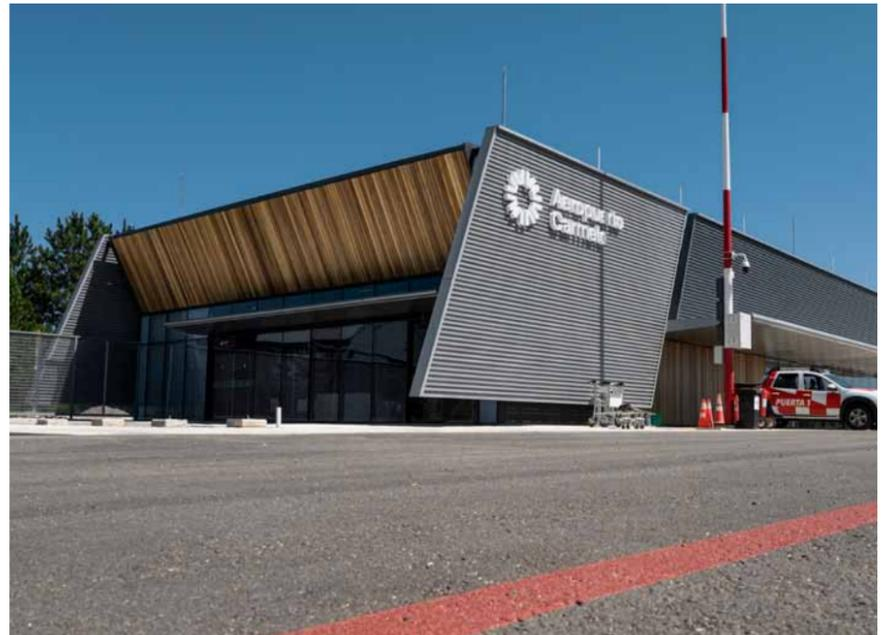
2: **Aeropuerto de Carmelo.** 600 m<sup>2</sup> de Paneles y 350 m<sup>2</sup> de Revestimiento . Productos Utilizados: ISODEC - CONCEPT WALL VISION
